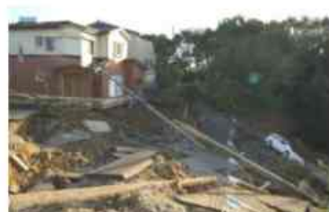
崩落した道路(川東丘陵地)
