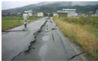
地盤沈下した道路(川東地区随所)
